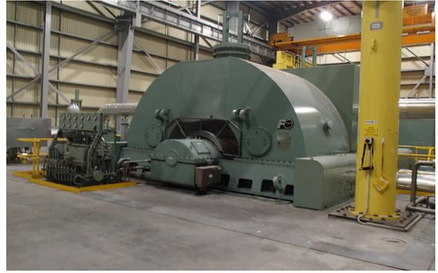
写真3 ナワプリア地熱発電所、タービン建屋内：単発では世界最大の発電機（日本製：富士電気）
