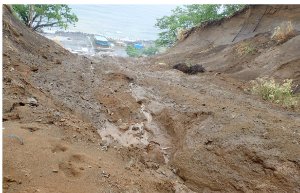
写真1 羅臼町で発生した緩斜面の崩壊
