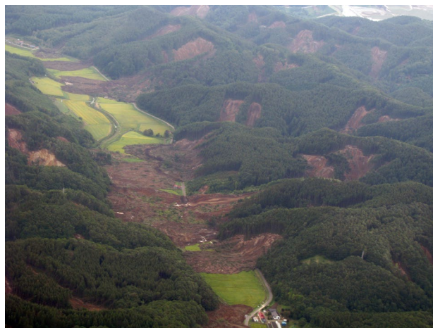
写真 1 斜面崩壊により住宅、道路、農地が被災
