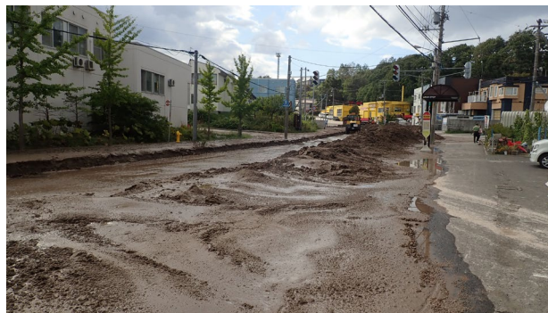
写真 2 谷埋め土が泥水となり流れ出し、道路を埋積
