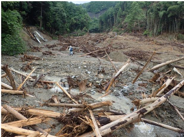
写真2 結晶片岩分布域（妙見川）の土石流の堆積状況
