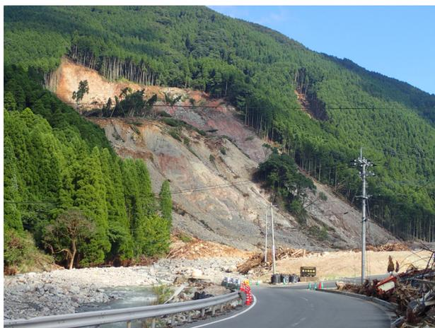
写真4 安山岩分布域（小野川）の大規模な斜面崩壊
