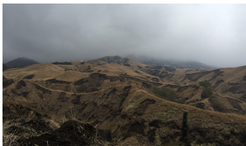
写真 1 調査地の崩壊斜面
