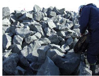
写真 トンネル工事による掘削土砂（岩石ズリ）
