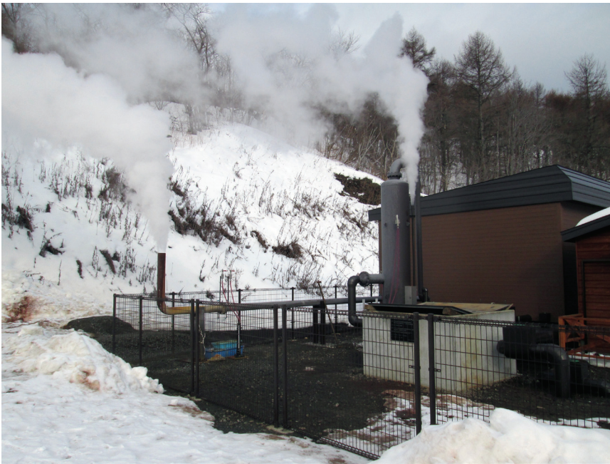
平成 25 年度に有珠山金比羅山火口付近で掘削した KH-1 井 現在、99.8℃の熱水と蒸気を揚湯しており、発電や熱利用への期待が膨らみます
