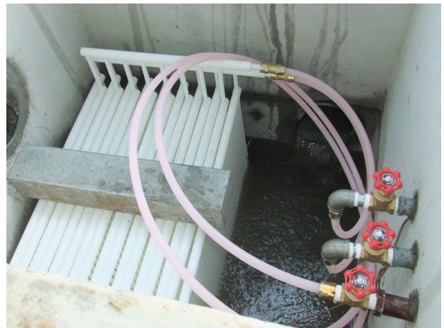
図3 排湯槽への熱交換器設置の様子
