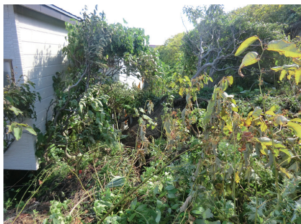
写真1 住宅背後で発生した崖崩れの土砂が住宅壁面にぶつかり停止している
