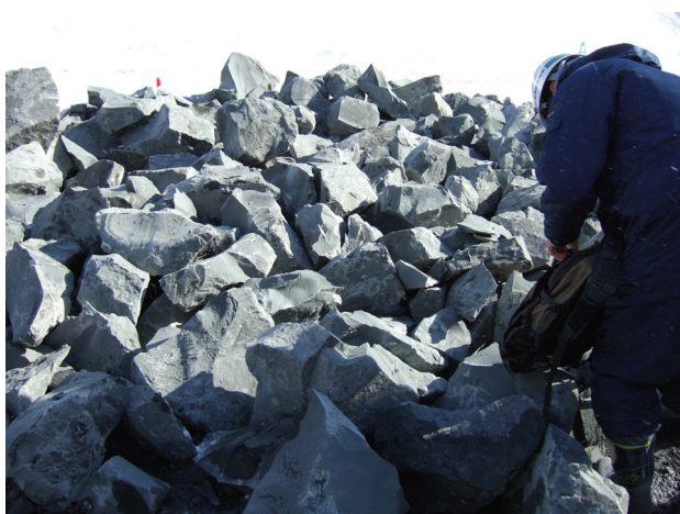
トンネル工事による掘削土砂(ズリ)
