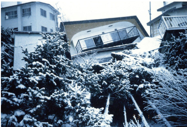
写真 1 釧路沖地震での釧路市緑ヶ丘の斜面崩壊
