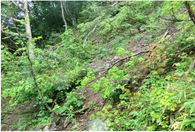
写真2 斜面中間部に薄く土砂が堆積する
