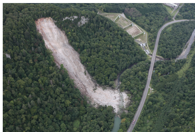
写真7 上空から見た斜面崩壊の全景 右に国道39号 （株）シン技術コンサル撮影）
