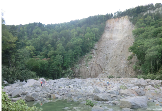
写真9 層雲峡四の岩付近の斜面崩壊
