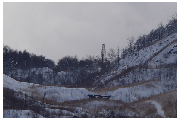
写真3 洞爺湖温泉の地熱資源調査掘削現場(金比羅山火口付近)
