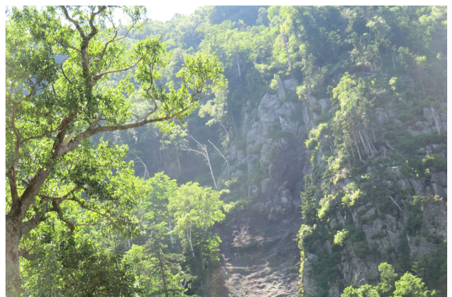
写真5 柱状節理が発達する崩壊斜面の最上部
