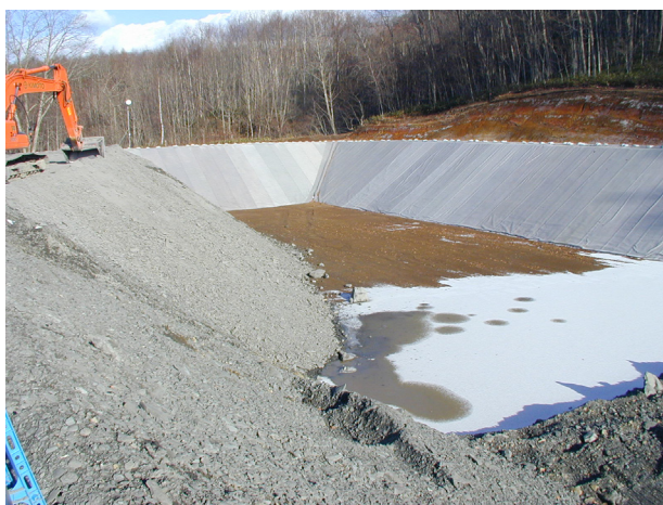
ダム工事において設けられた自然由来の砒素やセレンを含む土砂専用の堆積場
