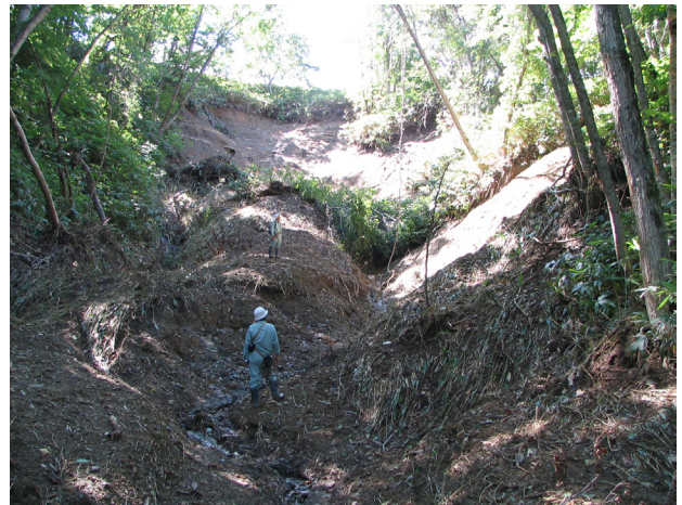
斜面崩壊の様子、表層の土壌が崩壊した。
