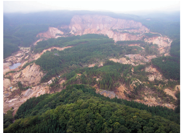
岩手・宮城内陸地震による荒砥沢地すべり
