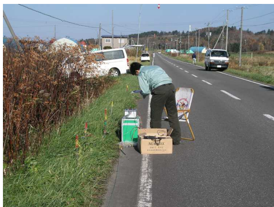
写真1 電気探査風景
