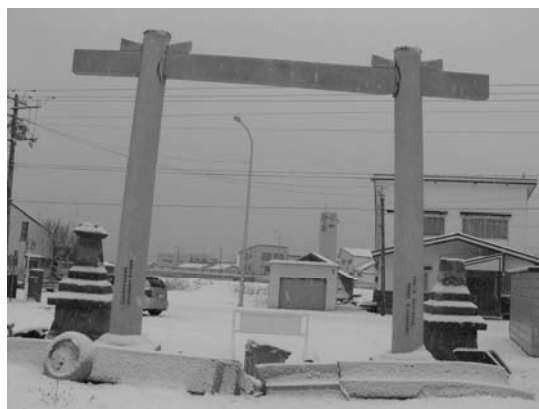
小平町港町の厳島神社（鳥居の上部が落ちている）
