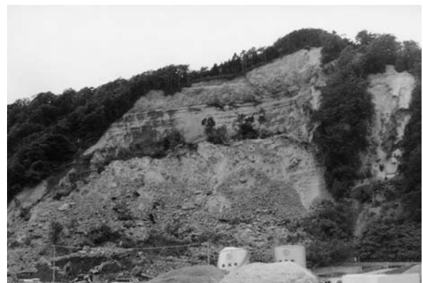
北海道南西沖地震による奥尻町観音山地すべり。多くの犠牲者を出した。
