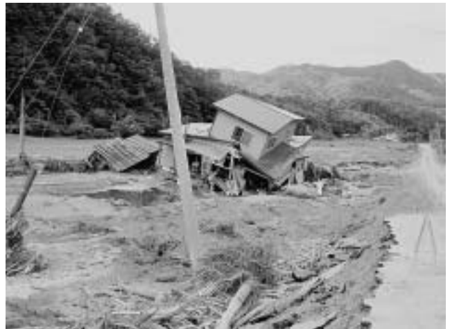
厚別川ブケマ橋付近の氾濫跡
