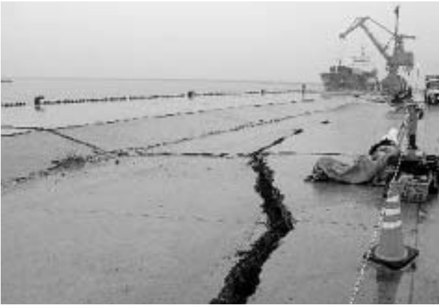
釧路西港第四埠頭：第三埠頭と比べても噴砂の規模が大きい。新規に造成した埠頭ほど液状化の程度が著しく、経時的な締め固めの程度の差異と推察される。(釧路市)
