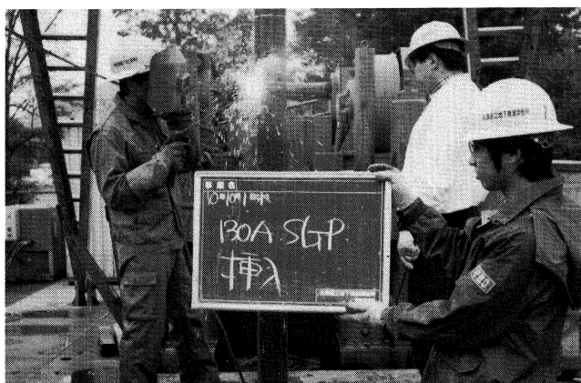
最終仕上げ管の挿入時の作業風景
