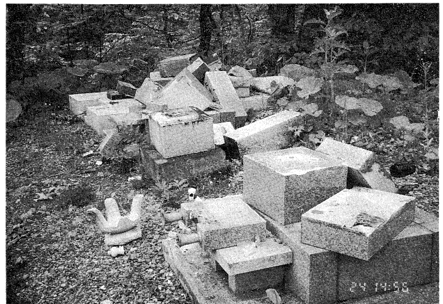
写真 新十津川町吉野共同墓地の地震被害
