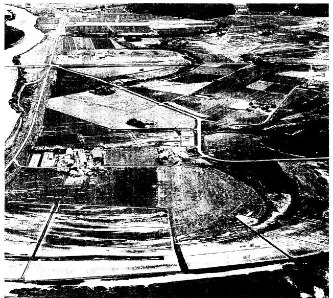
写真4 地震直後の航空写真から認められる地割れや噴砂の状況（北桧山町兜野地区）：シン技術コンサルタント撮影による
