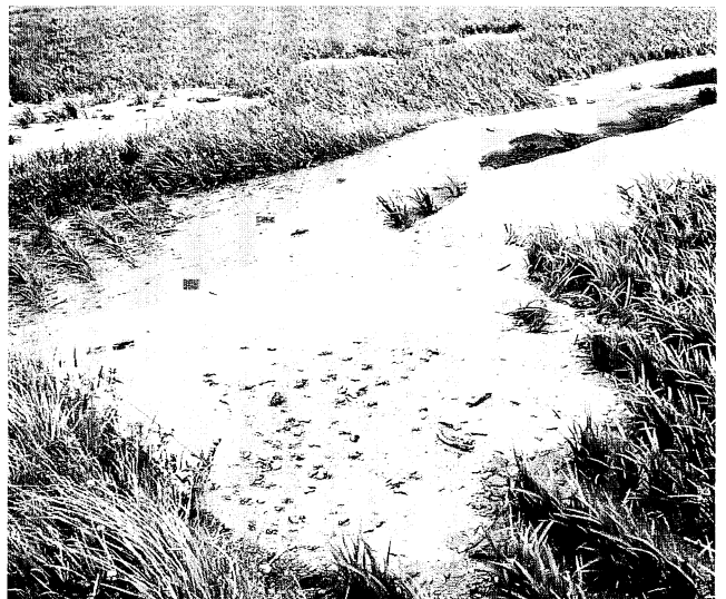
写真5 液状化による噴砂の状況（礫、木片なども噴出している）
