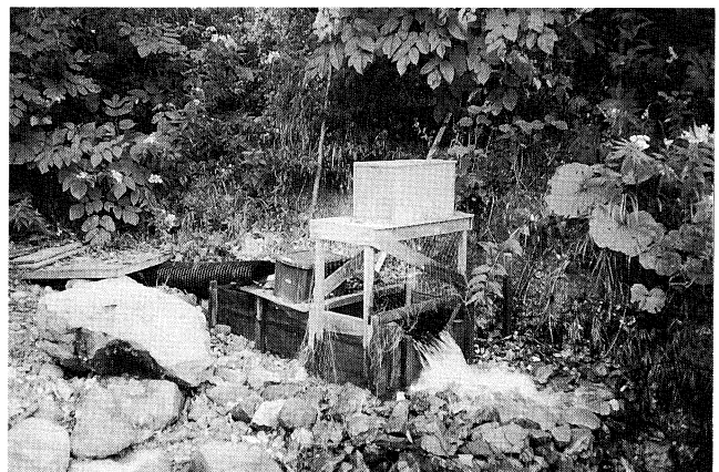
写真 中切坑における坑廃水の観測状況
