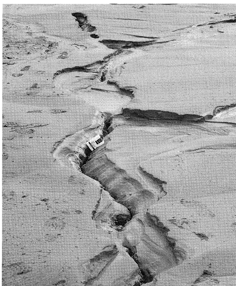
写真5 埋め立て地で見られた亀裂 (写真：浦河町提供)
