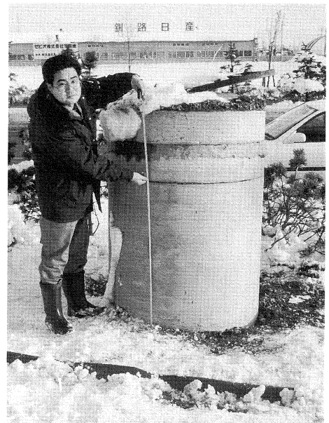
写真3 液状化による井戸の抜け上がり
