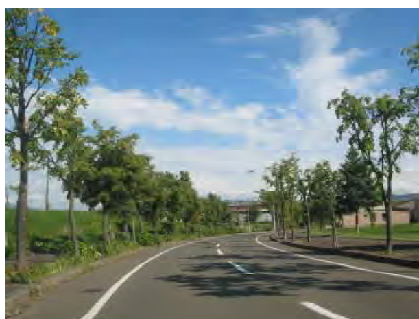
写真－Ⅱ－2 オオバボダイジュ並木によるカーブの視線誘導（富良野市）
