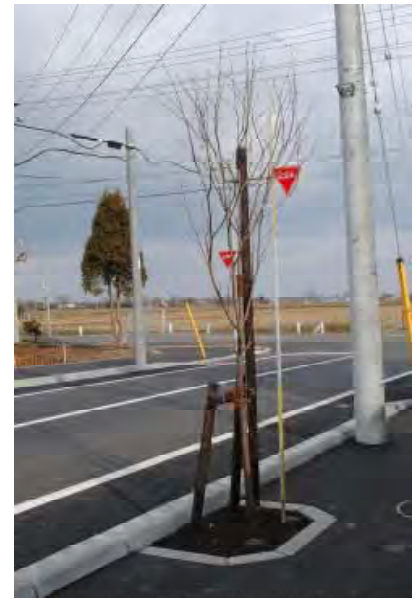
写真Ⅷ-2 街路樹の支柱
