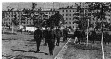
建設進む漁民住宅
