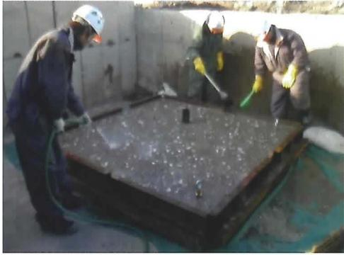
写真2 試験礁表面の洗い出し
