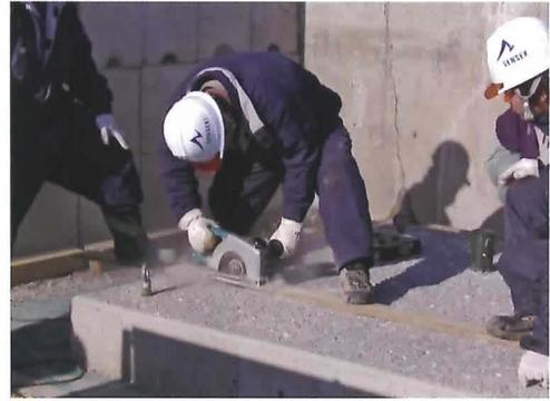
写真6 人工礁表面の溝切り
