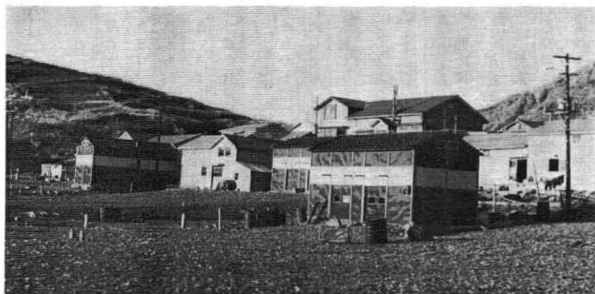
ハウス式コンブ乾燥施設（厚岸町筑紫恋）
