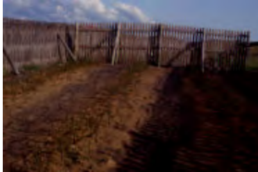
防風柵の設置、客土
