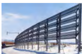
道路防雪用の鋼製フェンス
