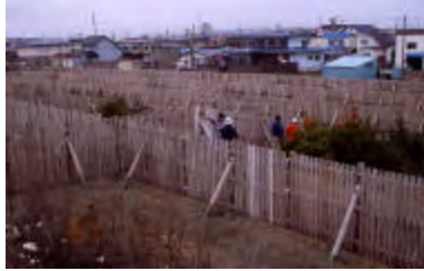
生活空間を守るための海岸林造成 (苫小牧市)
