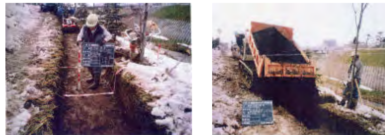
写真 - 6 - 3 列状客土の施工
