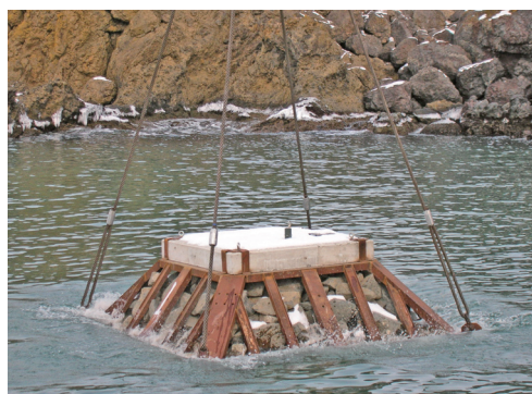
写真14 人工礁の設置
