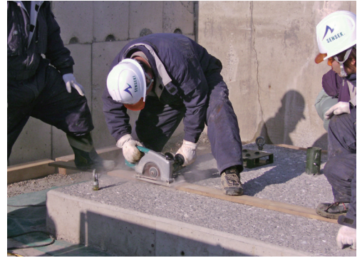
写真6 人工礁表面の溝切り
