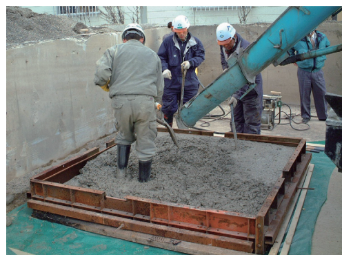
写真 1 人工礁型枠への打設
