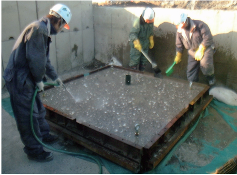
写真2 試験礁表面の洗い出し
