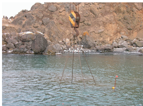
写真15 人工礁の設置
