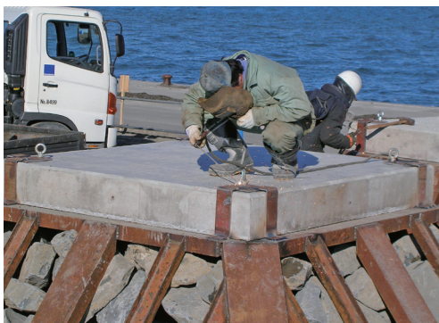
写真10 人工礁の台座取り付け
