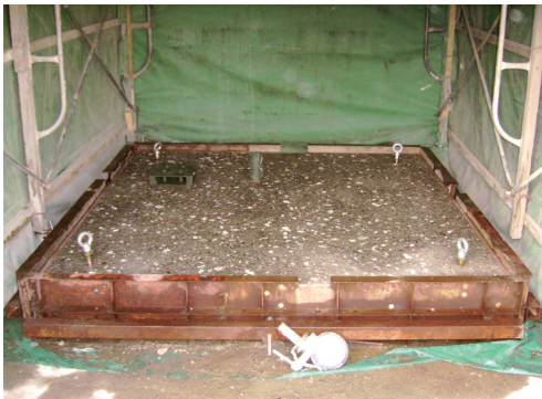
写真3 養生中の人工礁
