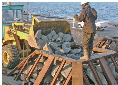
写真9 台座への割石詰め
