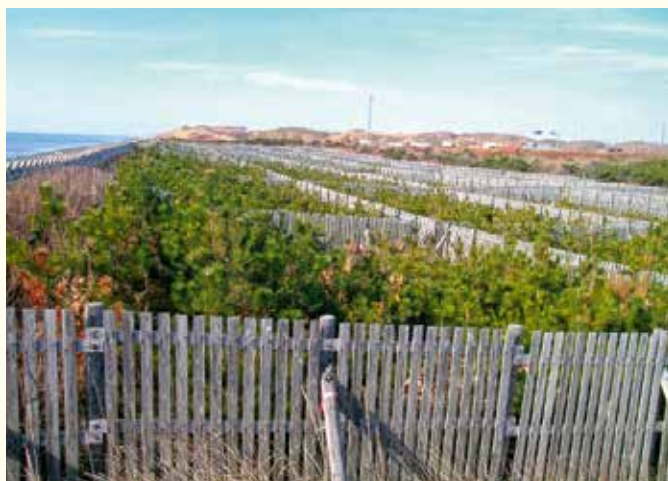
クロマツ海岸防災林の造成地 (日高町)
