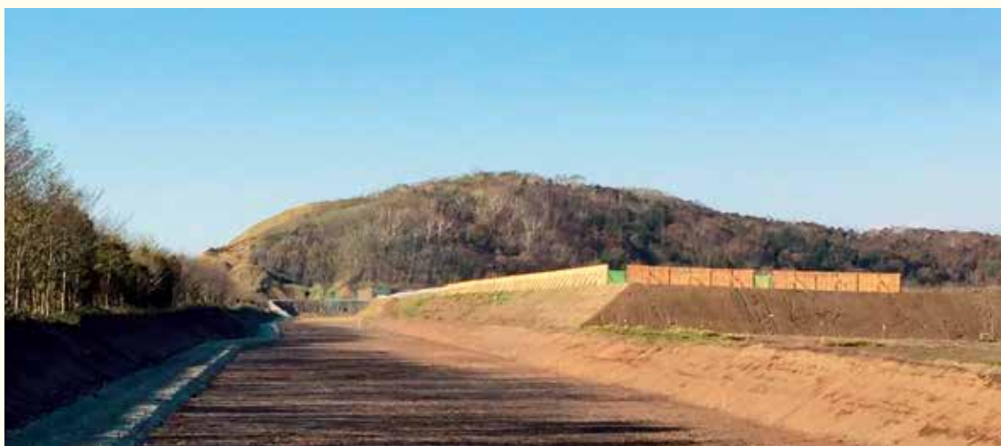
白糠町での堀と盛土の造成例
