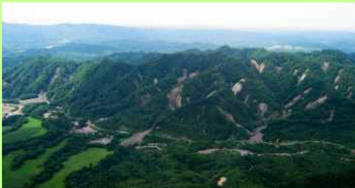
2003年 台風10号厚別川山腹崩壊 (茶色が崩壊・堆積箇所)
