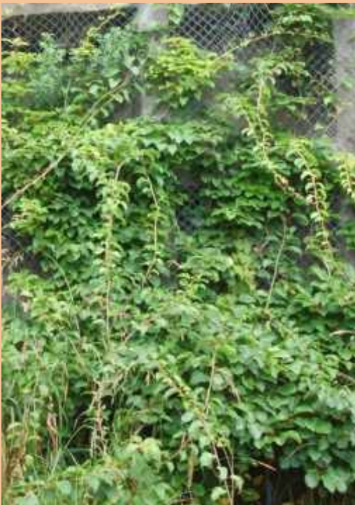
金網にからんでコンクリートの壁面を覆う
