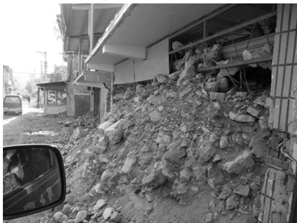
写真2 大甲溪支線における土石流跡
