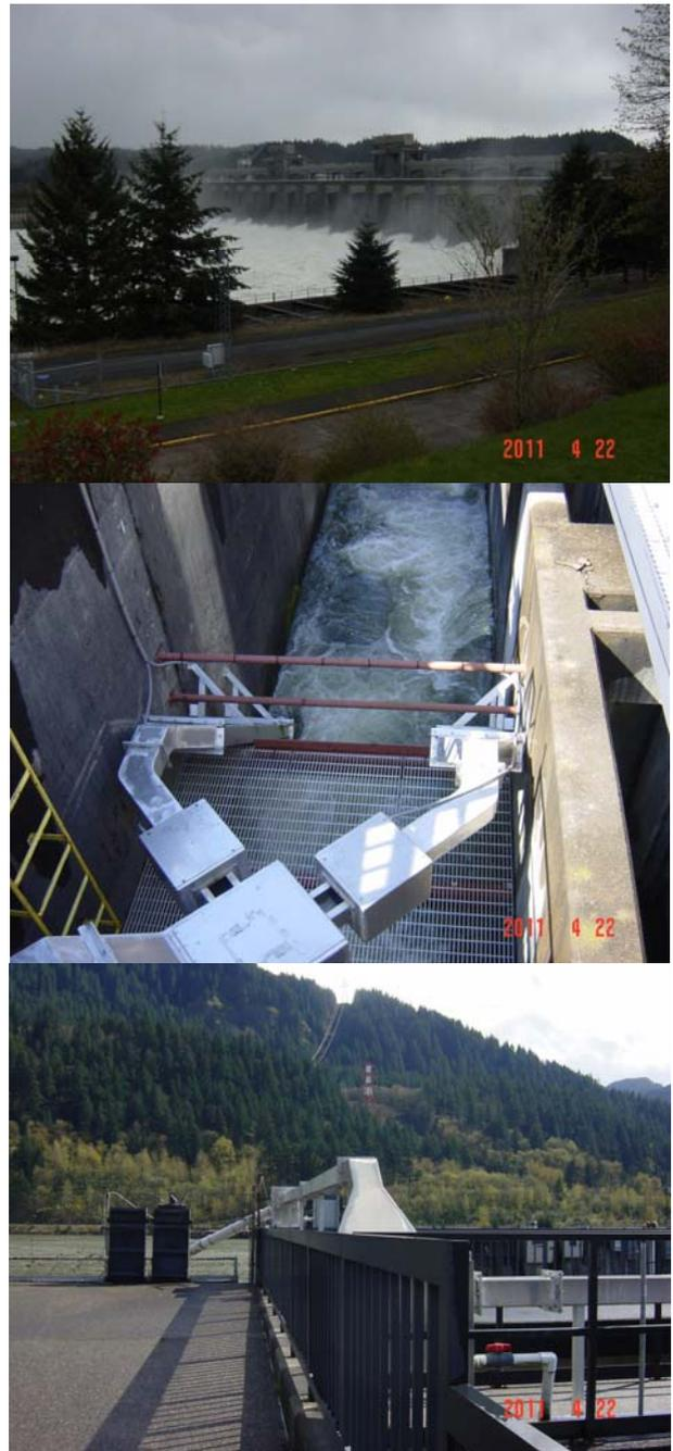
写真4 ボナビルダムに設置されたヤツメウナギ専用の魚道 1 番上の写真はボナビルダムで発電タービンを通過した水が排水されている。2 番目の写真はサケ科魚類などが利用する魚道で、アルミの管がヤツメウナギの魚道である。内部は格子状になっており、ヤツメウナギは体をくねらせて遡上する。3 番目の写真は、魚道上部であり、アルミ管の奥を親魚が通過することで、ダム上流へ遡上したことになる。
