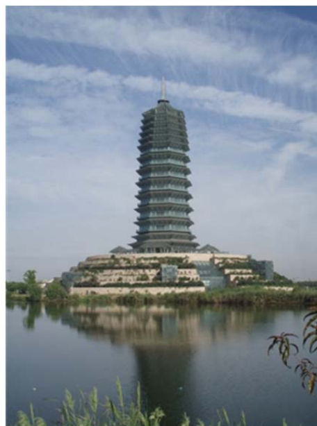
外装のみが完成していた中国水利博物館
