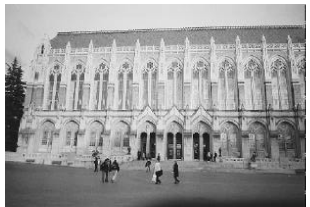
写真5 ワシントン大学構内
