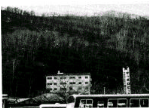
写真 - 1 調査地No.1の外観（1985.11.20）
