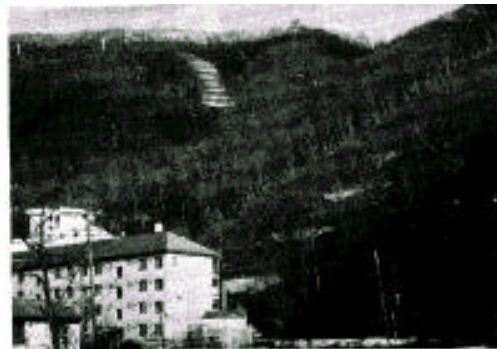
写真 - 2 調査地No.2の外観（1985.11.20）
