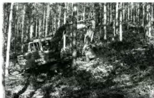
写真 - 1 本道に導入されたフランス製ブラッシュカッタ ベースマシンには国産のパワーショベルを利用。
