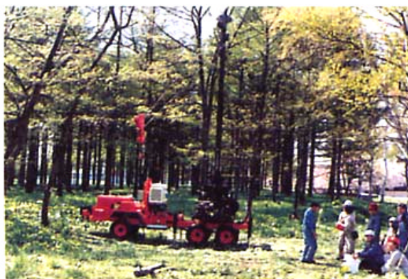
写真 - 5 現場に導入されたタワーヤード
