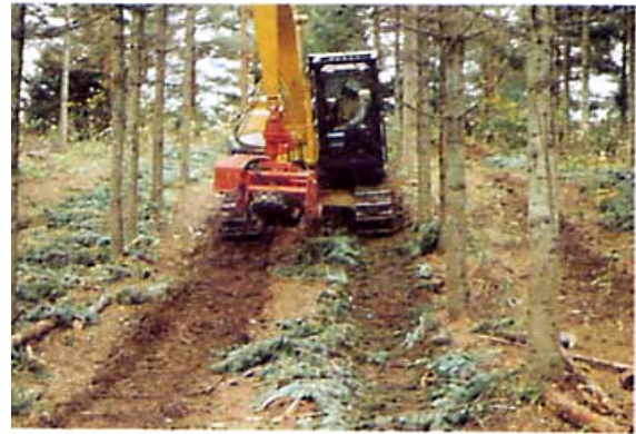
写真 - 2 走行試験中のエクスカベータ
