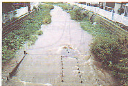
写真-3 同地点における大雨による出水時の様子
