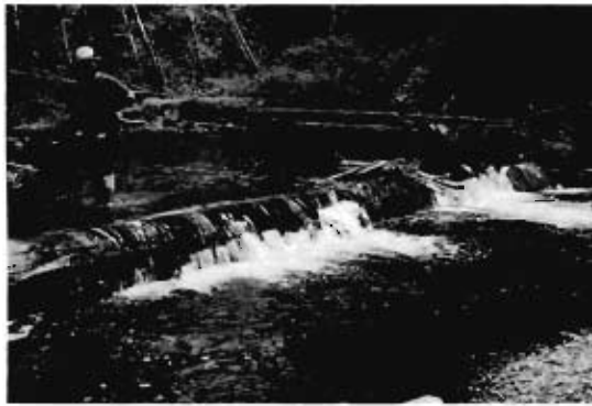
写真-2 オレゴン州国有林における樹木を使った溪流工法 (a) ログダム、 (b) ウエッジダム
