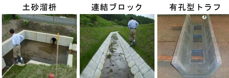
図 1 排水路整備に導入された魚類への配慮工法
