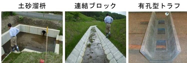
図 1 排水路整備に導入された魚類への配慮工法
