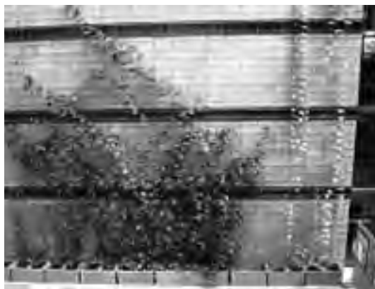
写真 - 1 壁面緑化の様子 (平成15年9月：植栽後3ヶ月)
