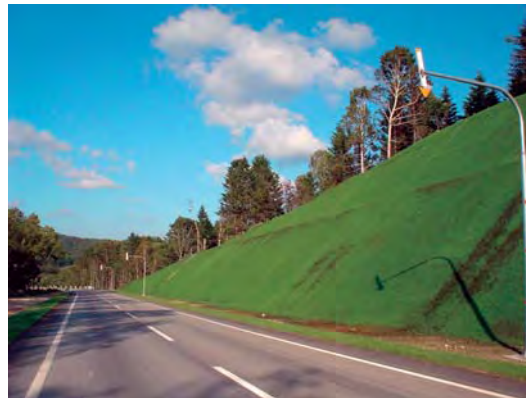
写真－2 牧草類を用いた急速緑化
