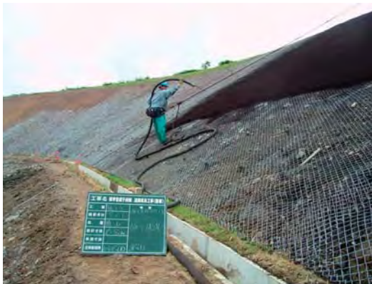
写真－1 植生基材吹付工法
