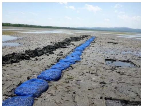
写真2 網袋の敷設状況
