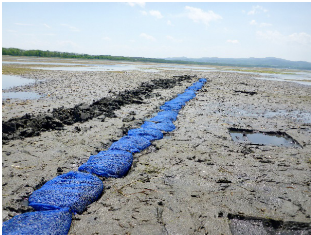
写真1 網袋の設置状況
