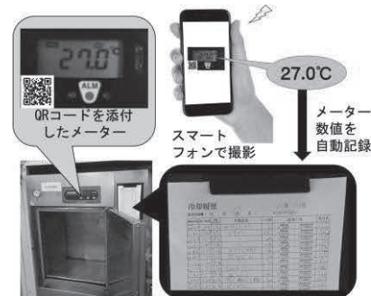
図4 既存設備のメーター読取
