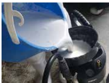
ポータブルの吹付機器への充填 (簡単な攪拌で乳状を維持)
