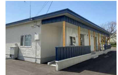
安平町が被災者向けに整備した公的賃貸住宅
