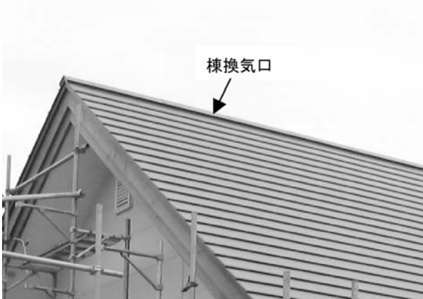
写真3 棟換気併用軒天換気方式の例
