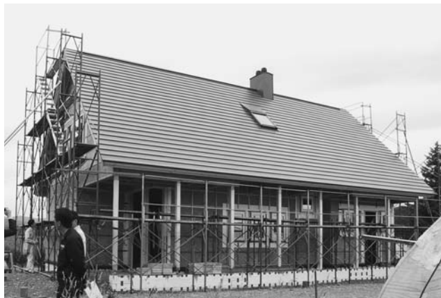
(2) 施工中の外観
