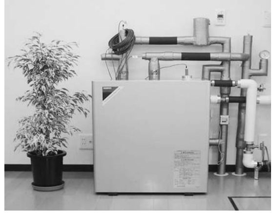
写真1 地熱ヒートポンプの例
