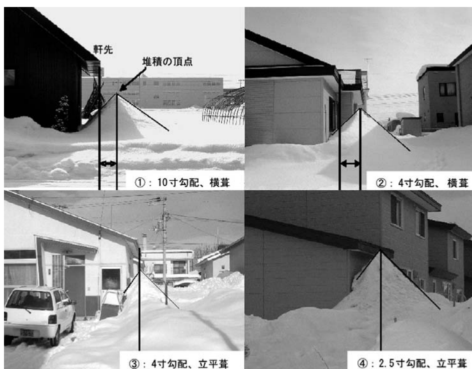
写真2 屋根勾配と葺工法別にみた落雪状況
