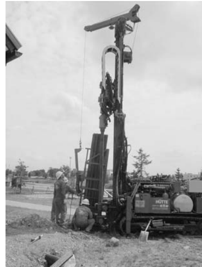
写真2 地中熱交換器の設置工事
