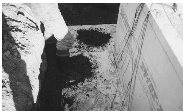
写真2 スカート断熱の施工例
