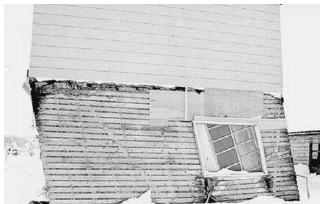
写真1 結露により構造躯体が腐食した住宅
