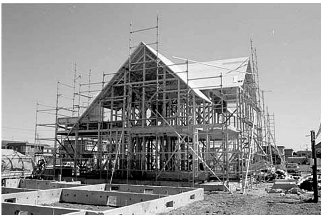
写真1 木造住宅の建設（在来軸組構法）
