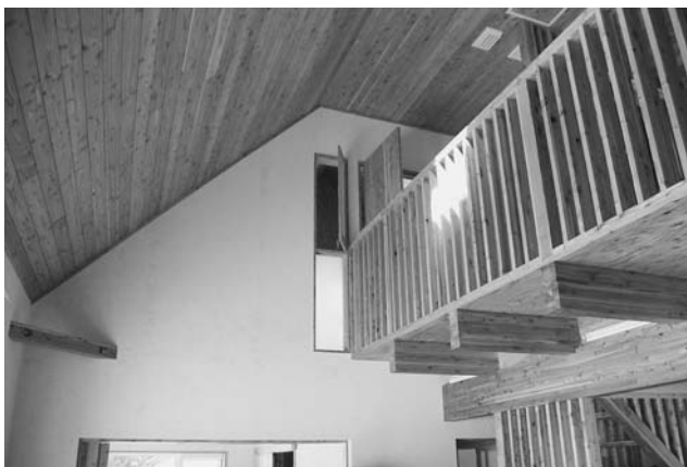
(3) 完成時の室内
