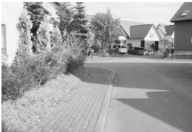
写真2 外壁後退の例（旭川市／ウッドタウン緑が丘）
