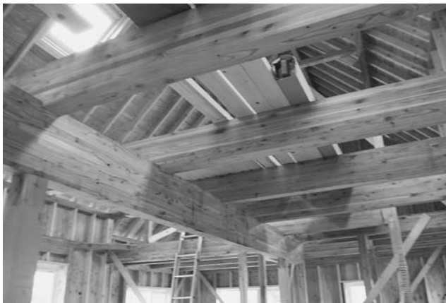
(1) 施工中の室内
