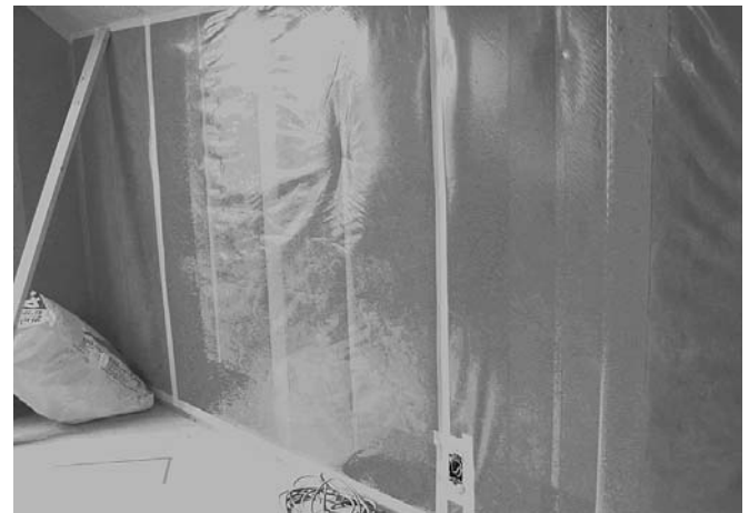
写真2 壁の防湿気密フィルムの施工例
