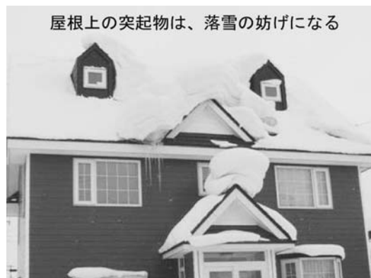
写真1 複雑な屋根計上での落雪障害
